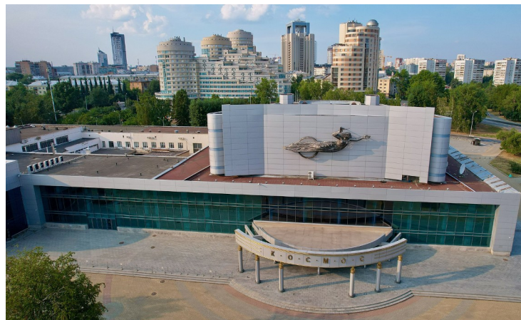
ККТ «Космос» после реконструкции
